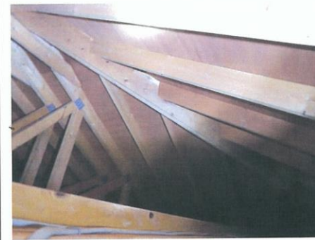
⑥屋根裏の状態
